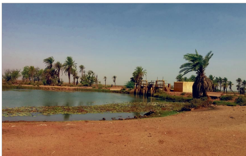
Im Office du Niger regulieren Schleusen die Wasserstände in den großen, mittleren und kleinen Kanälen – das Wasser fließt einzig aufgrund von Höhenunterschieden. [Foto: Olaf Bernau]
