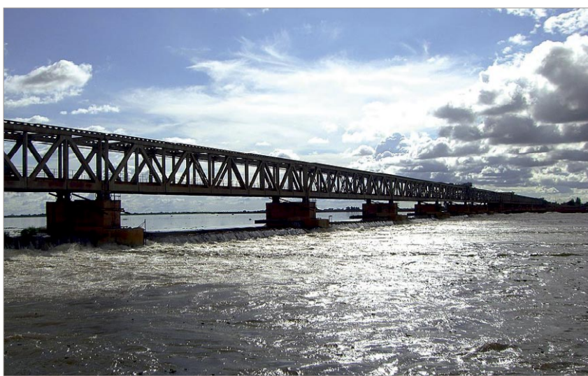
Bei Markala wird der 800 Meter breite Niger-Strom um 5,5 Meter gestaut, um das Kanalsystem des Bewässerungsgebiets des Office du Niger zu fluten. [Foto: Wikipedia]
